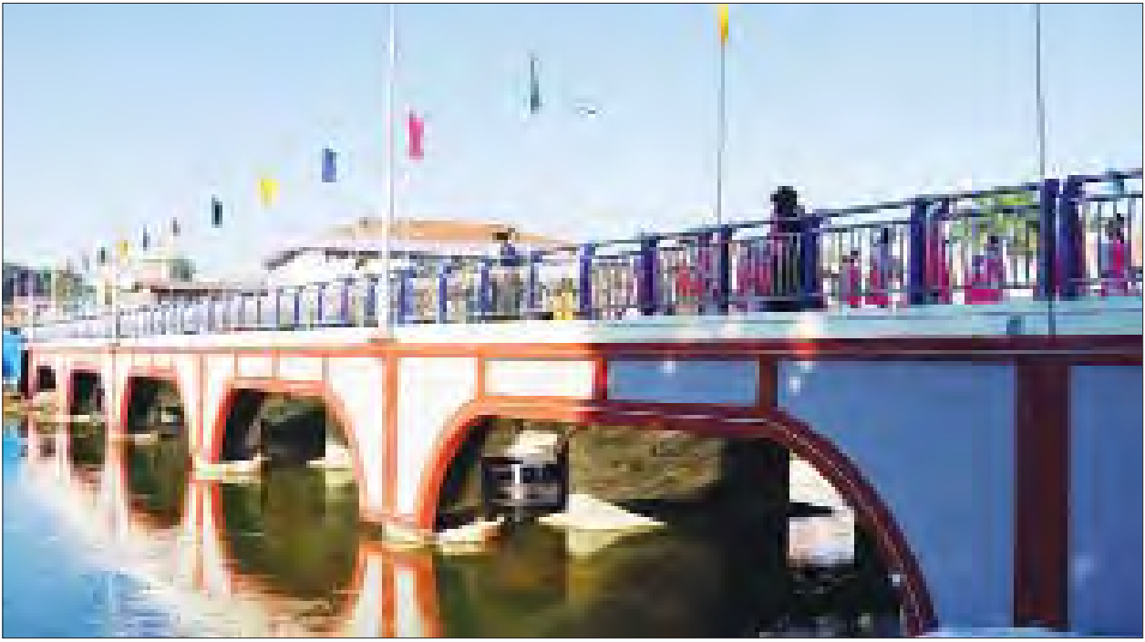
လမ်းသွား အကျယ် ၄၄ ပေ၊ တံတားအရှည် ၃၀၄ ပေ ၉ လက်မကို ၂၀၁၉ ခုနှစ် ဧပြီ ၄ ရက်မှ စတင်အဆင့်မြှင့်တင်ဆောင်ရွက်ခြင်းကို တံတားအထူးအဖွဲ့ (၆) နေပြည်တော်က တာဝန်ယူတည်ဆောက်ခဲ့ခြင်းဖြစ်ကြောင်း သိရသည်။ ထွန်းလေး
